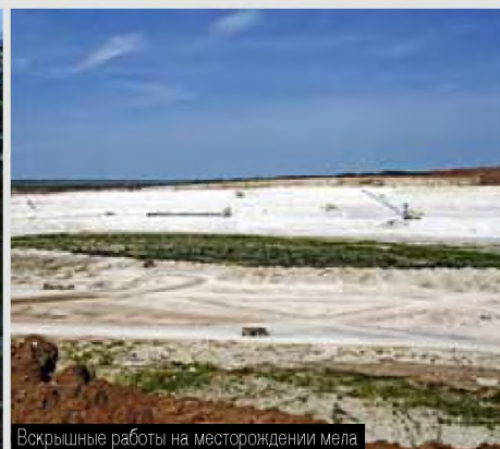
Вскрышные работы на месторождении мела
