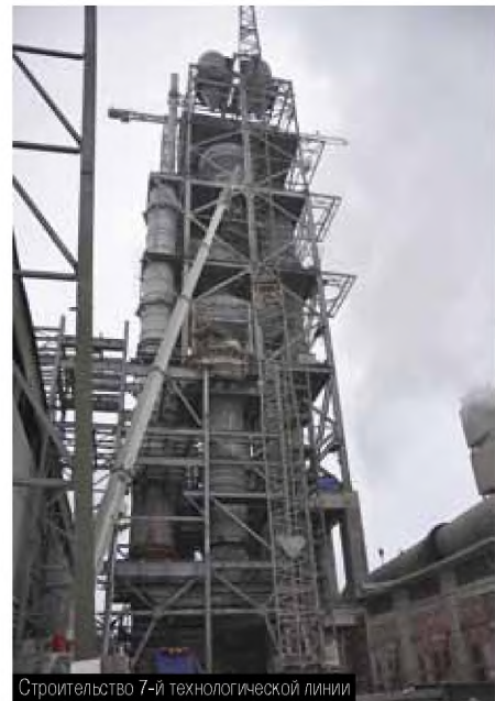
Строительство 7-й технологической линии
