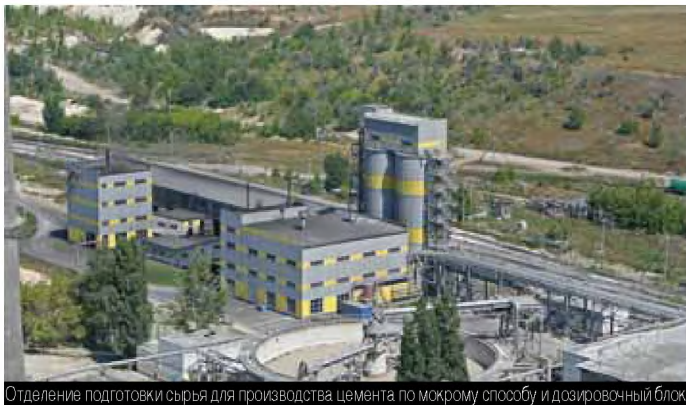
Отделение подготовки сырья для производства цемента по мокрому способу и дозирочный бункер
